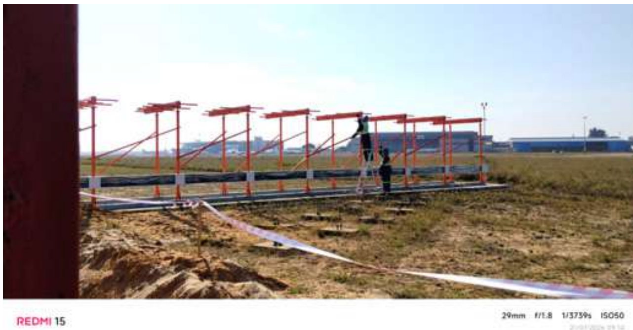
Instalação do sistema ILS — Projecto JICS, em curso
